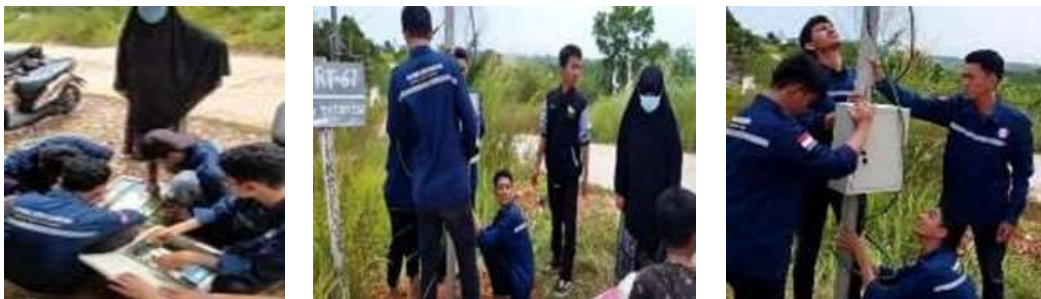
Gambar 3. Merakit komponen-komponen penerangan lampu jalan tenagasurya pada boks panel dan tiang PJU
