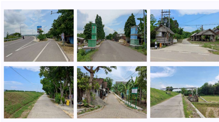
Gambar 7. Kondisi Jaringan Jalan pada Wilayah Desa Semambung
