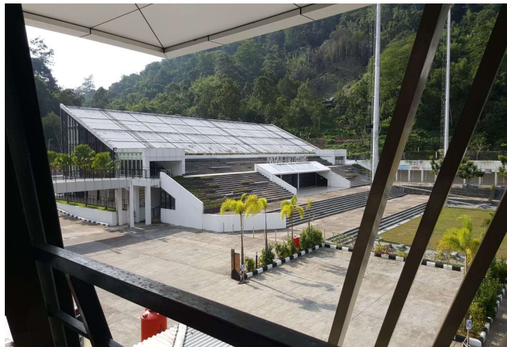
Gambar 3. Deretan pertokoan yang tutup karena tidak ada yang menggunakannya.
