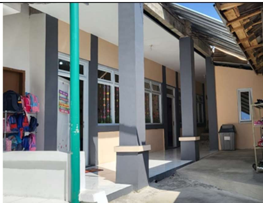
Kondisi Bangunan Eksisting Site
