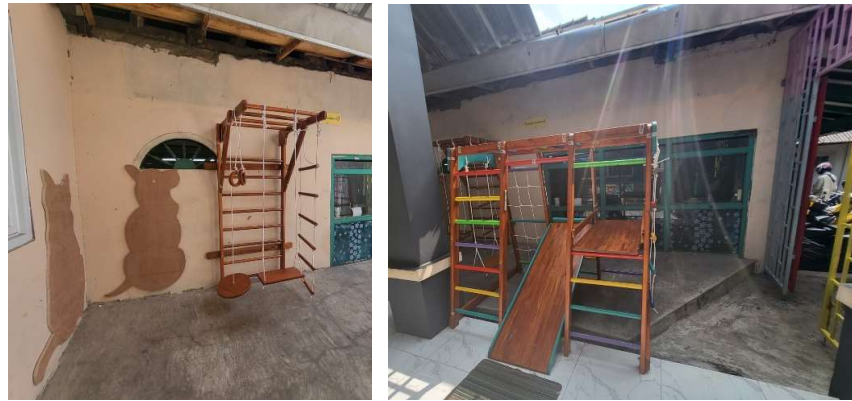
Gambar 5. Pemasangan permainan anak pada area bermain
