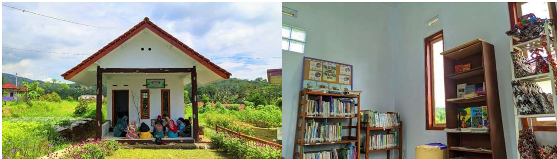
Gambar 2. Kondisi TBM Di Kampung Bungur Desa Jalatrang
