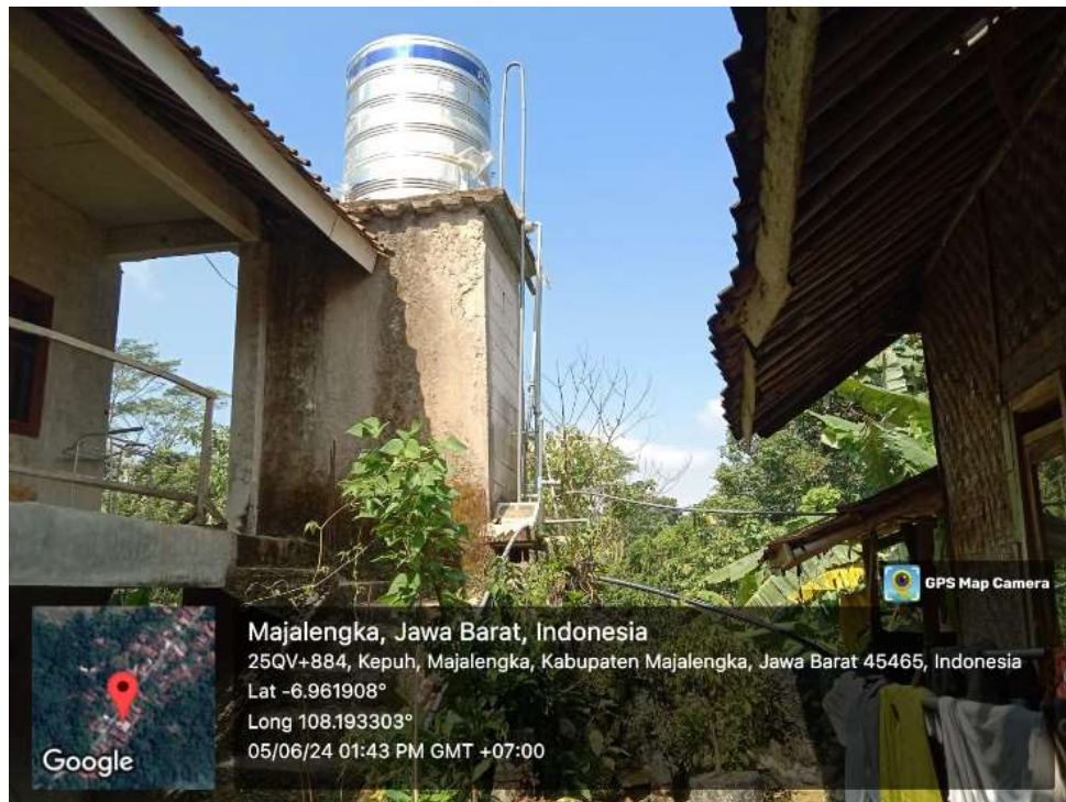
Gambar 5. Sumber air untuk aliran ke masjid
