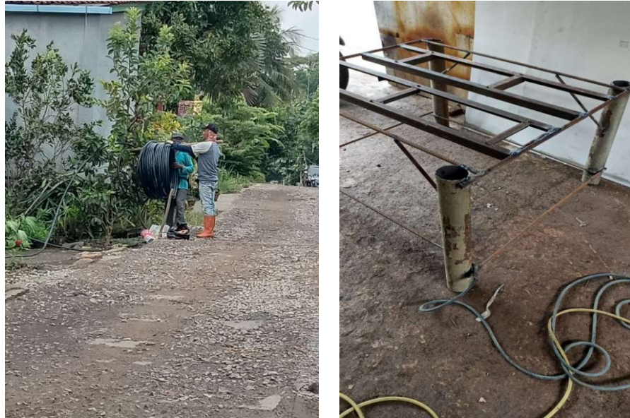
Gambar 6. Persiapan pipa HDPE dan dudukan tandon air
