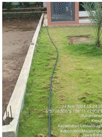
Gambar 8. Pemasangan pipa HDPE dan tandon air
