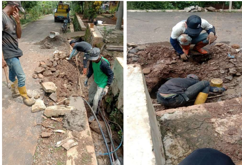
Gambar 7. Penggalian untuk jaringan pipa HDPE
