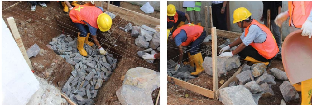
Gambar 4. Penyiapan lubang fondasi dan pemasangan batu belah
