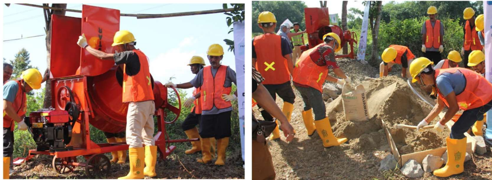
Gambar 6. Pembuatan campuran beton menggunakan concrete mixer
