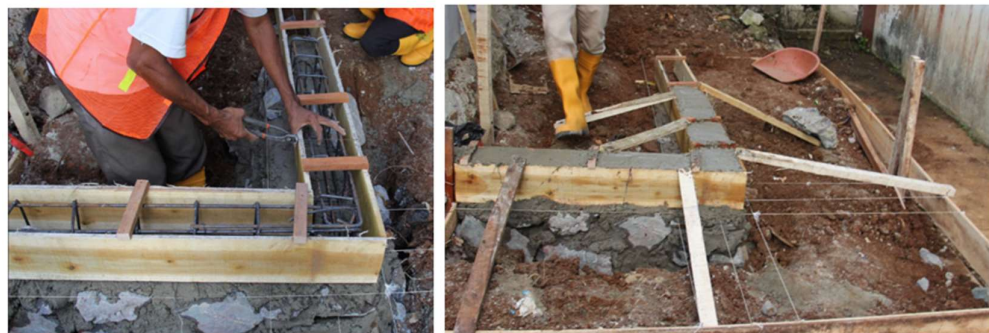
Gambar 7. Pemasangan besi sloof , pemasangan bekisting dan pengecoran
