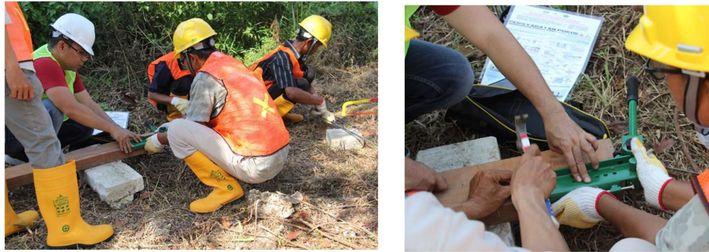
Gambar 5. Pembuatan pembesian sloof menggunakan alat penekuk besi
