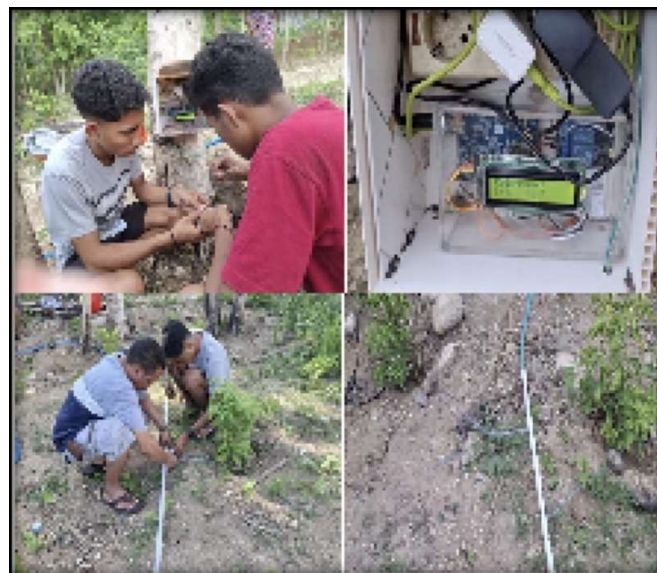
Gambar 4. Pengerjaan Instalasi dan Setelah Instalasi
