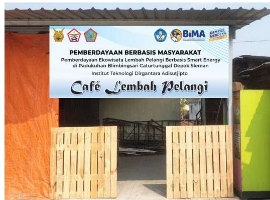
Gambar 8. Pemasangan papan nama dan persiapan café lembah pelangi
