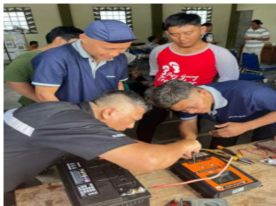
Gambar 6. Warga dan tim pengabdian mempersiapkan instalasi pembangkit listrik tenaga surya
