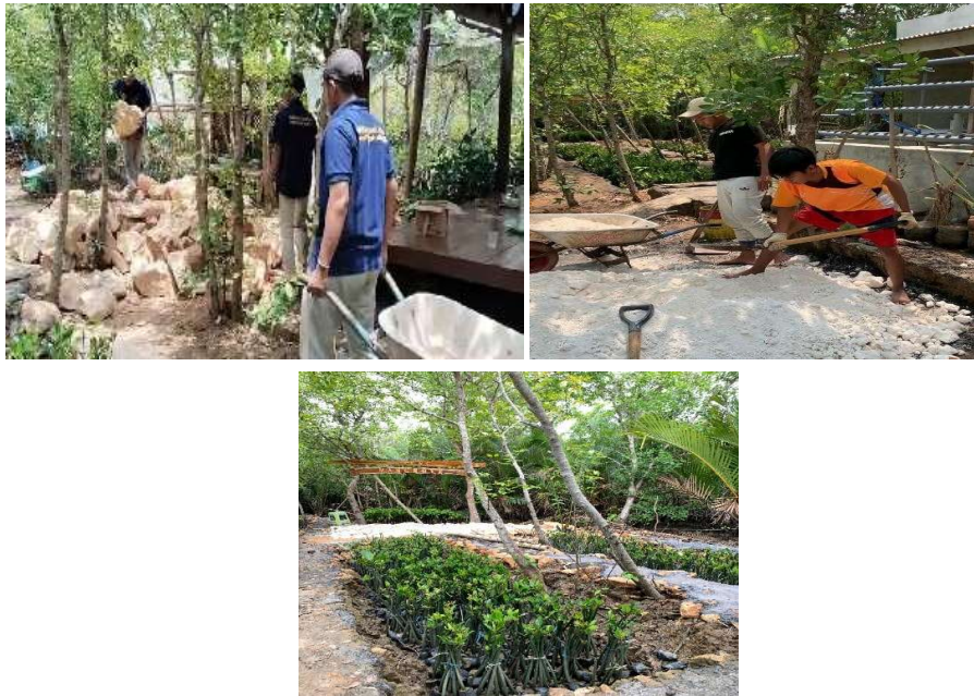
Gambar 3. Pembuatan jalan setapak ekowisata Saung Mangrove
