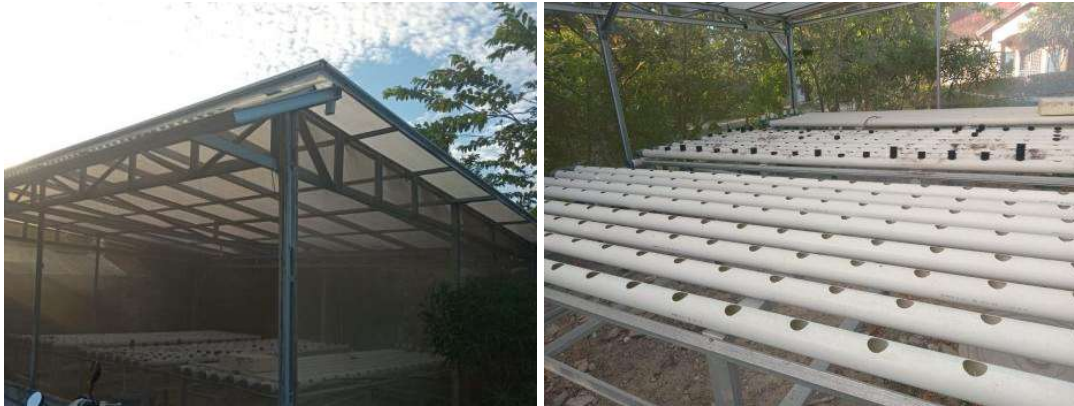
Gambar 1. Instalasi Hidroponik Sistem NFT KWT Mekar Berkarya
