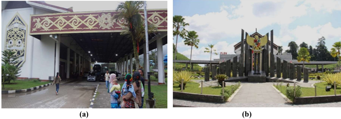
Gambar 1. (a) PLBN Entikong sebelum direnovasi, (b) PLBN Entikong setelah direnovasi
