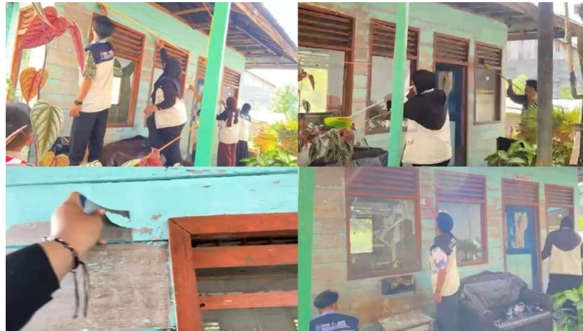
Gambar 3. Proses persiapan revitalisasi melalui pembersihan dan pengikisan cat lama
