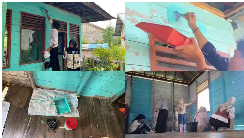
Gambar 4. Proses pengecatan dinding, pintu, dan jendela fasilitas keagamaan
