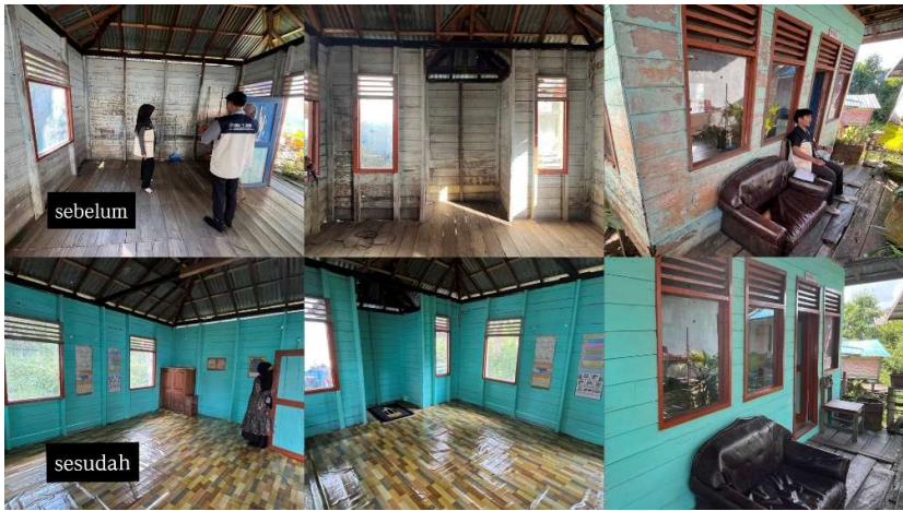
Gambar 7. Kondisi fasilitas keagamaan sebelum dan sesudah revitalisasi
