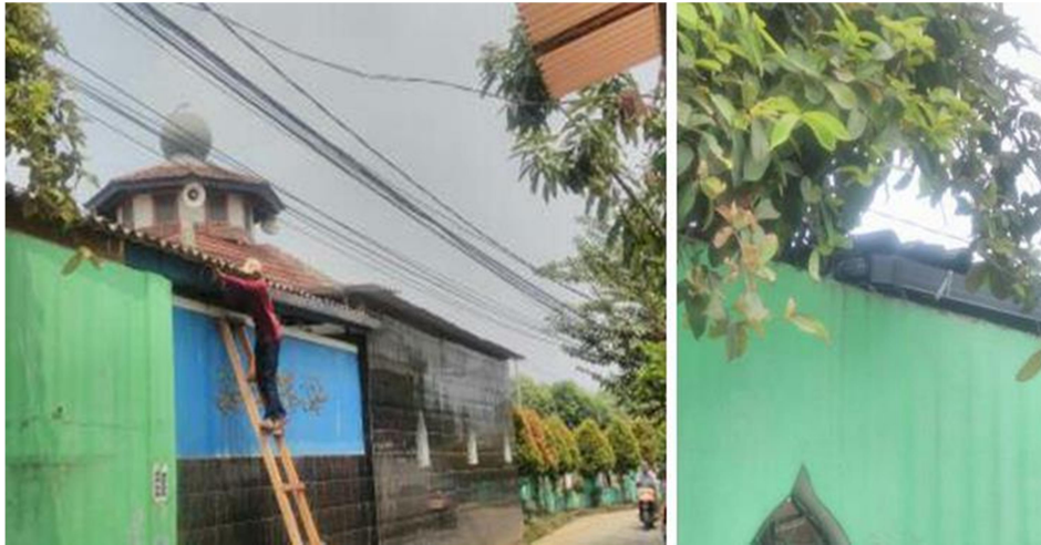
Gambar 4. Pemasangan Talang Pada Atap Toilet dan Tempat Wudhu
