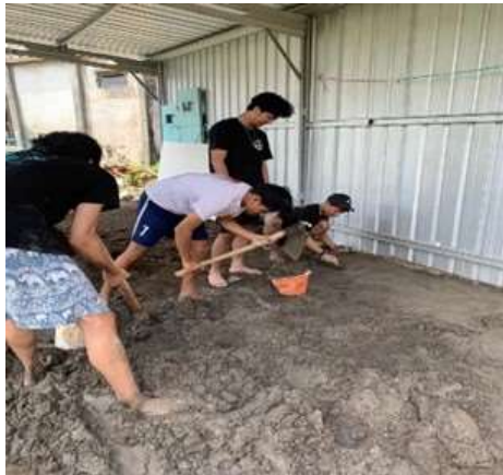
Gambar 7. Proses Pemerataan Adonan Beton
