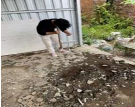
Gambar 5. Proses Pemerataan Lantai Kantin
