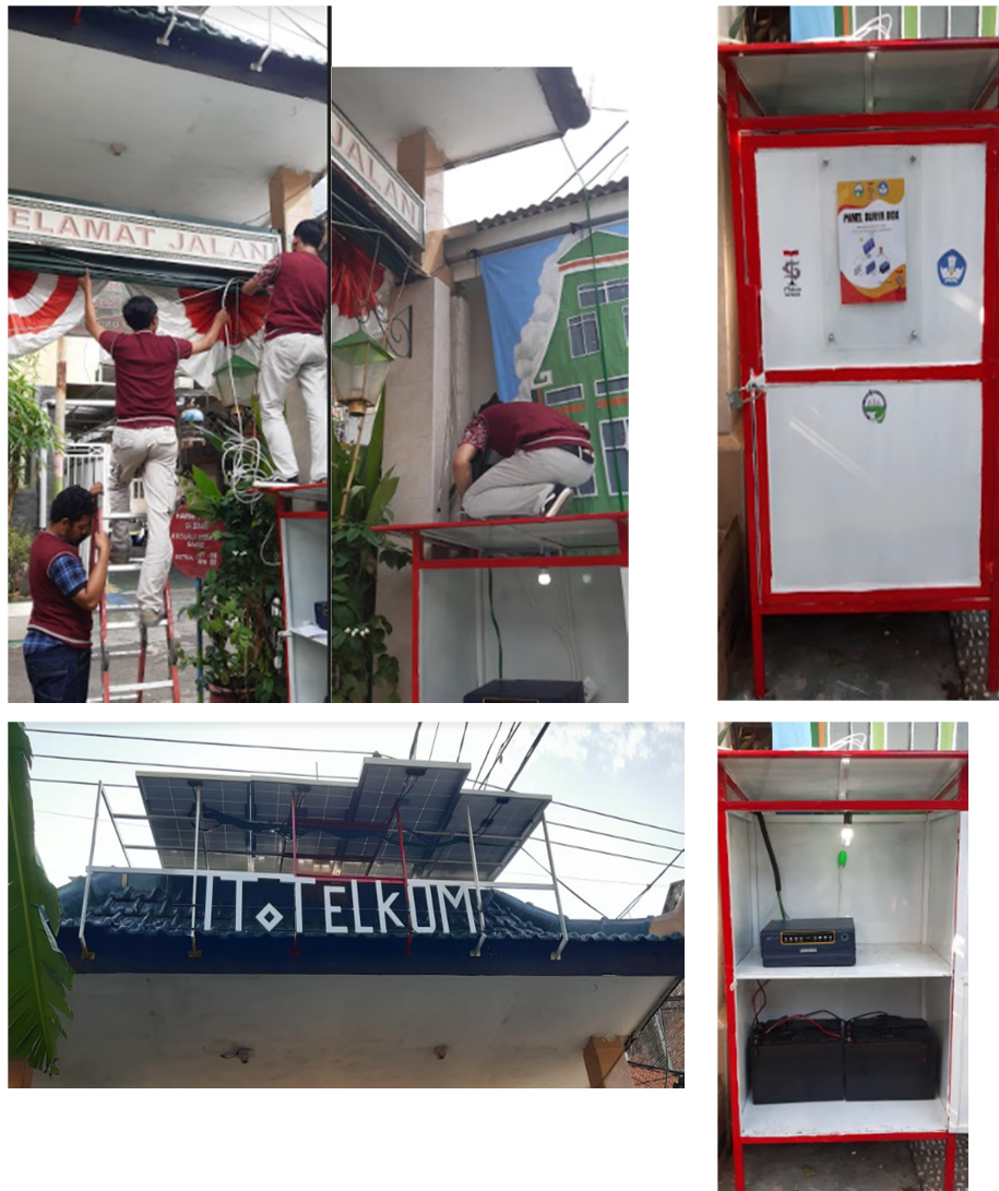
Gambar 8. Proses Pemasangan/Instalasi Panel Surya
