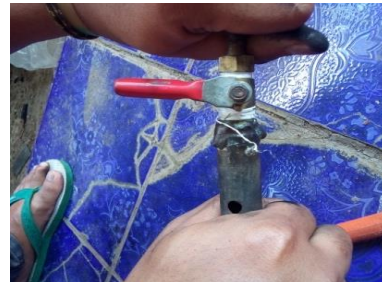
Gambar 16. Pemasangan Kran pengatur Api
