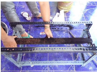
Gambar 13. pemasangan plat penahan panas
