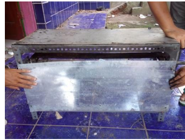
Gambar 15. pemasangan penutup samping
