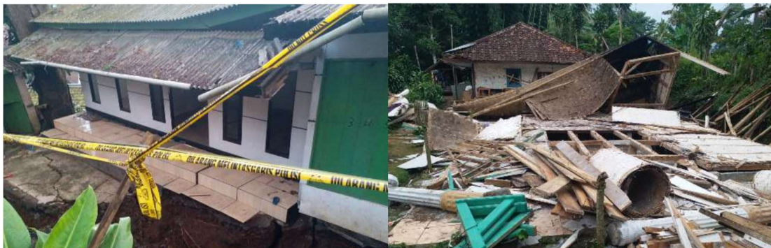
Gambar 1. Rumah-Rumah Warga yang Terkena Bencana Longsor di Desa Kertaangsana, Kecamatan Nyalindung, Kabupaten Sukabumi
